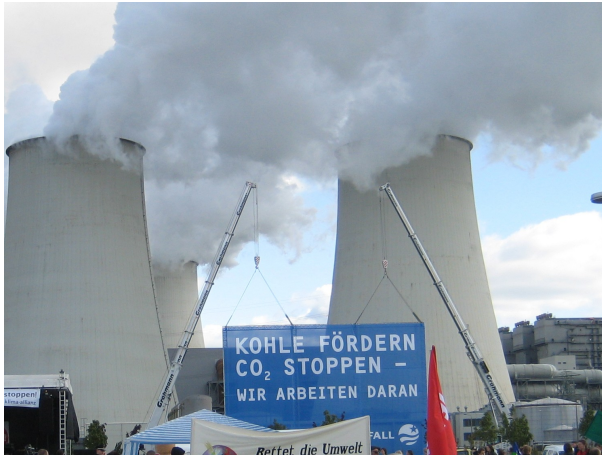
Abbildung: Kraftwerk Jänschwalde
